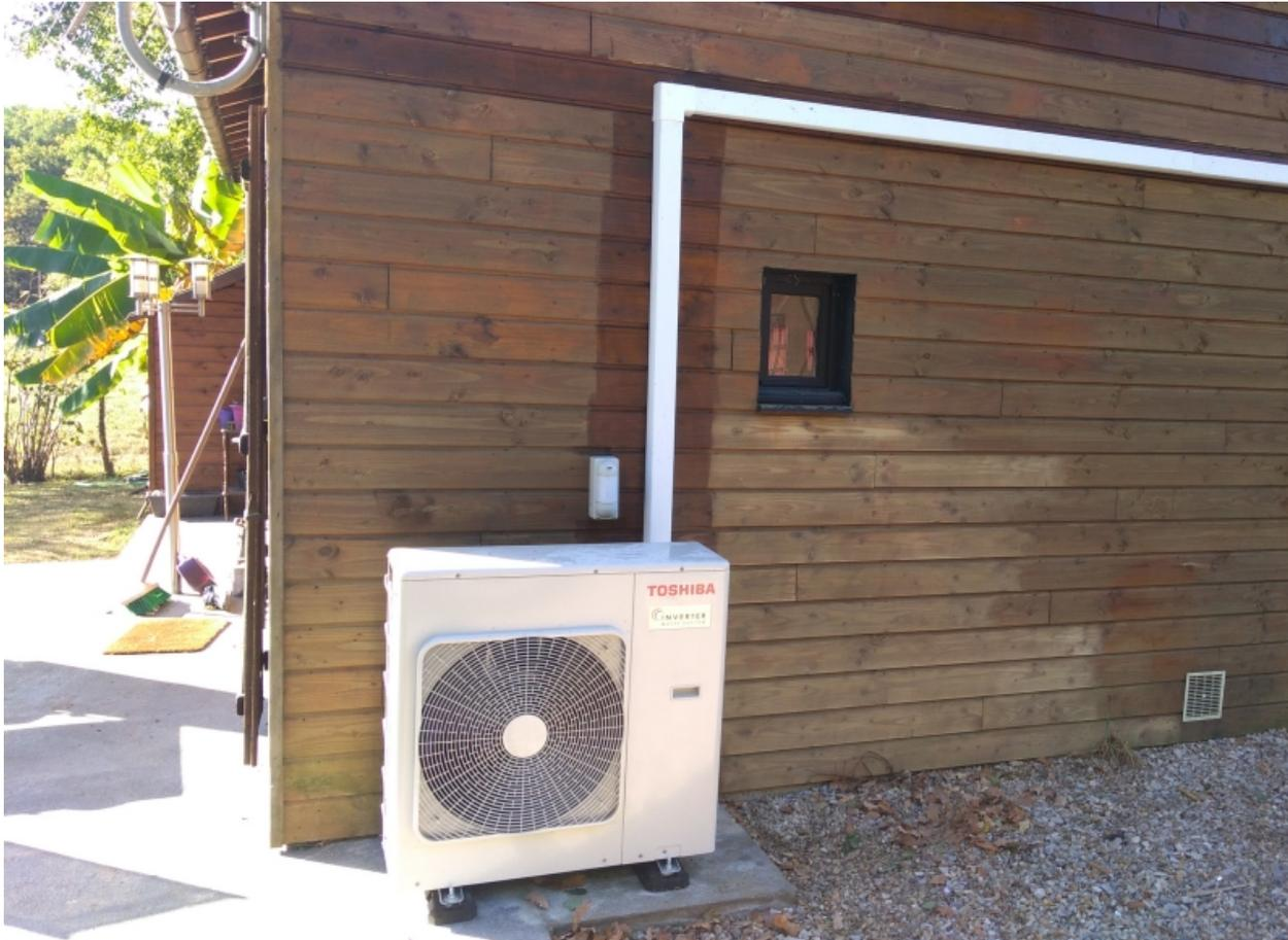
*Nous avons installé un multiplit 2 voies TOSHIBA réversible afin de chauffer et climatiser un chalet de 80m chauffé jusqu'à présent avec des convecteurs électriques très énergivores. Notre technicien a effectué la mise en service. Nous avons proposé à notre client un contrat d'entretien annuel.*
