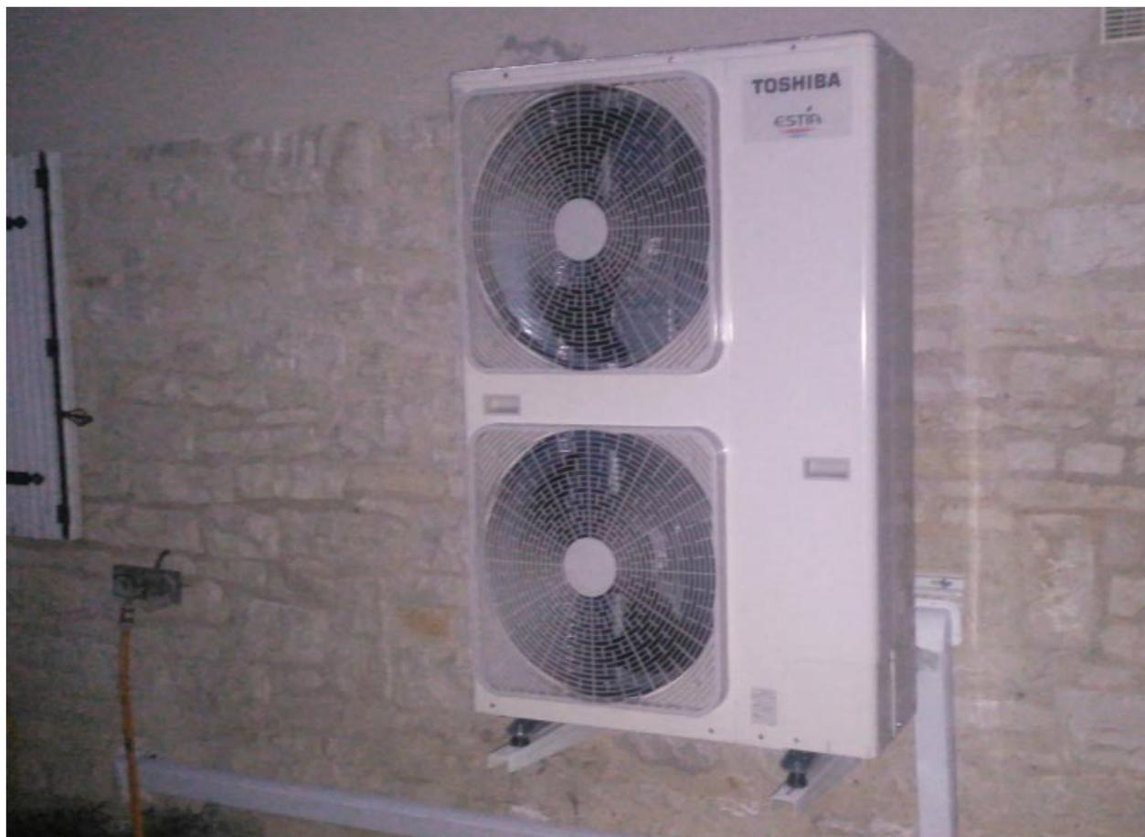
*nous avons installé une Pompe à Chaleur TOSHIBA EXTREME de 8kW (puissance à -15° extérieure). Cet appareil fonctionne jusqu'à une température extérieure de -25°.*
