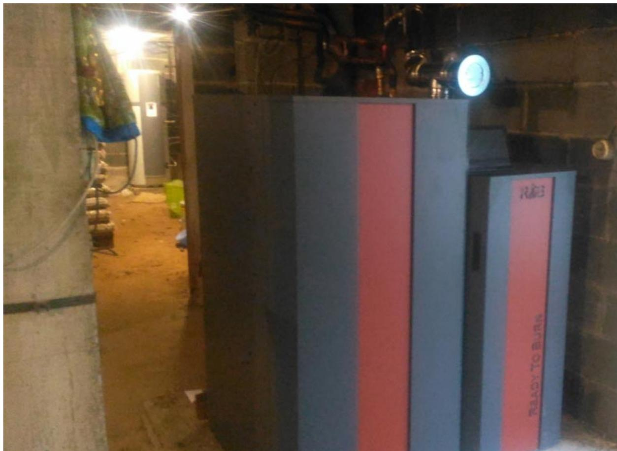
*Nous avons remplacé une chaudière fioul par une chaudière à granulés de bois Suedoise Type RTB 15KW de marque NBE. Le bruleur de cette chaudière permet une modulation de puissance exceptionnelle: Elle varie de 10 à 100% Plus la modulation est importante, plus la chaudière sera capable de s'adapter aux besoins réels de l'installation, en assurant une combustion et un rendement optimal.*
