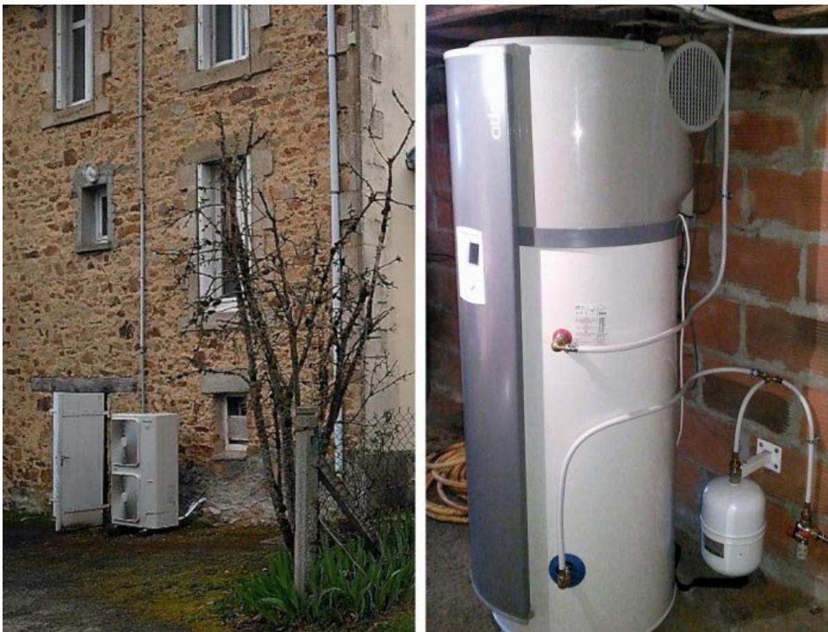
*Dans le cadre d'une réhabilitation d'une maison de village comprenant quatre habitants, nous avons installé un chauffe eau Thermodynamique de 200 litres de marque ATLANTIC. Cet appareil de classe énergétique A permet de réaliser jusqu'à 75% d'économie par rapport à un chauffe eau classique.*
