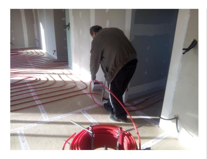
Dans le cadre de la construction d'une maison neuve de 80m², nous avons installé un plancher chauffant alimenté par une Pompe A Chaleur TOSHIBA ESTIA 8KW . L'eau de chauffage est filtrée avec un filtre dégazeur Heifi Top de marque Judo
