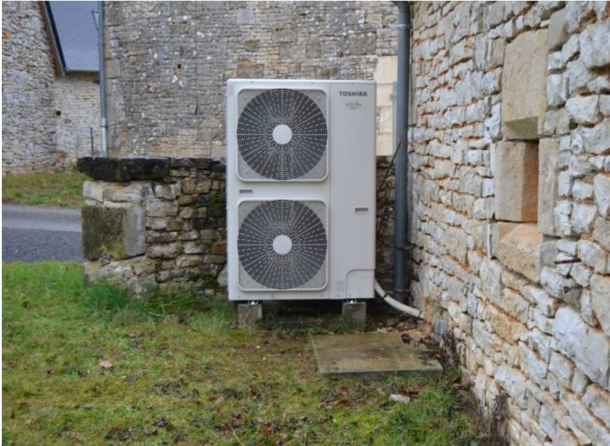
*Installation d'une pompe à chaleur Toshiba sur un réseau de plancher chauffant à eau chaude avec un chauffe eau Thermodynamique Atlantic 300 litres.*
