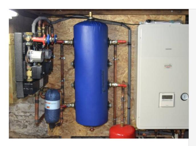
Installation d'une pompe à chaleur Toshiba sur un réseau de radiateurs fonte existant
