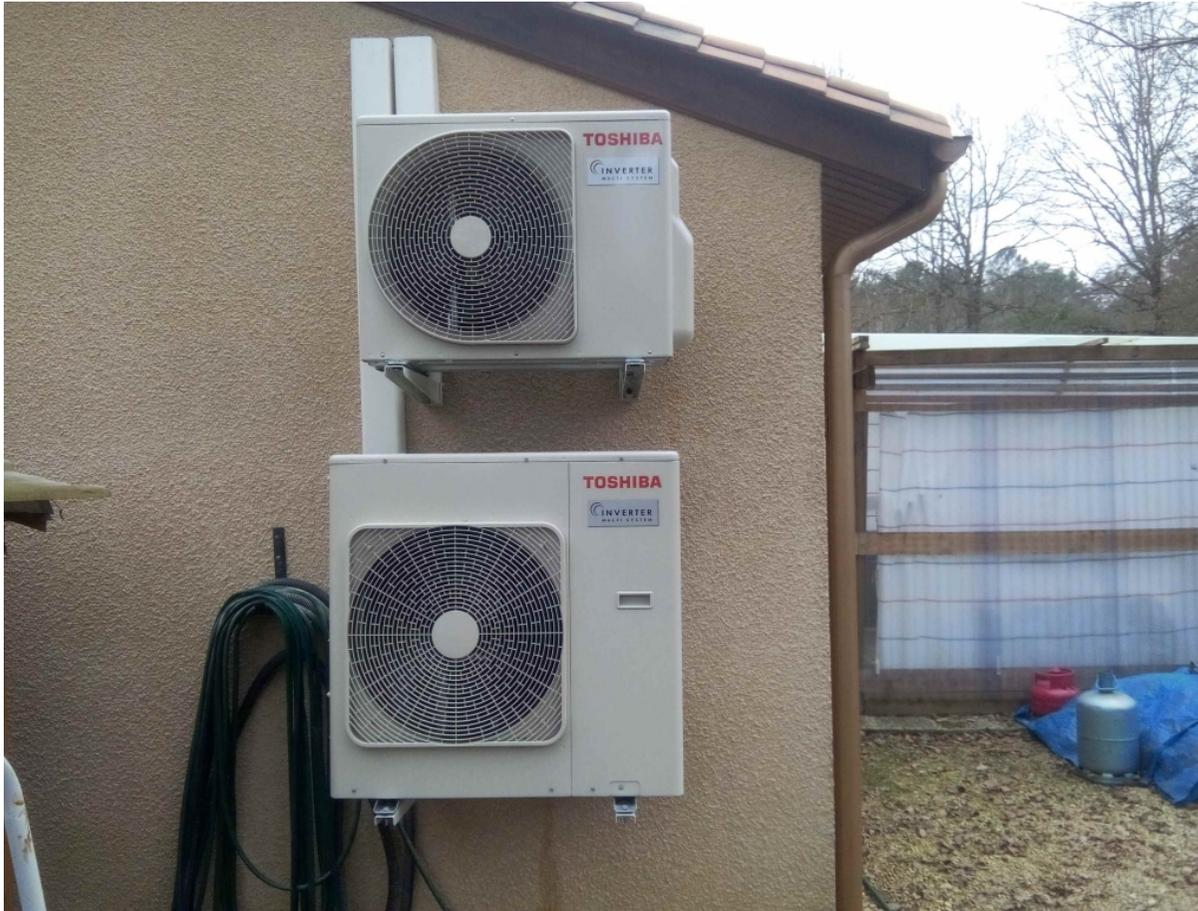
*Nous avons installé un multiplit 5 voies ainsi qu'un Bi-splits TOSHIBA réversible afin de chauffer et climatiser un pavillon de 110m chauffé jusqu'à présent avec des convecteurs électriques très énergivores et un poêle à bois.*
