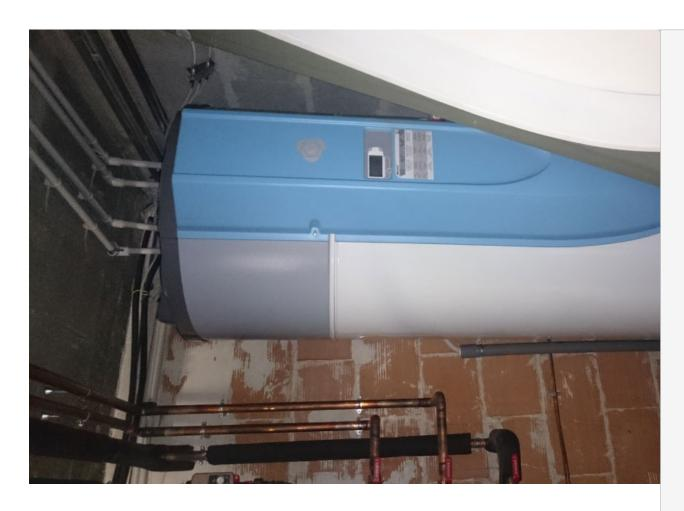
Dans le cadre d'une réhabilitation d'une maison de ville de 140m² sur 2 niveaux, nous avons installé un chauffe eau Thermodynamique de 270 litres de marque ATLANTIC. Cet appareil de classe énergétique A permet de réaliser jusqu'à 75% d'économie par rapport à un chauffe eau classique.
