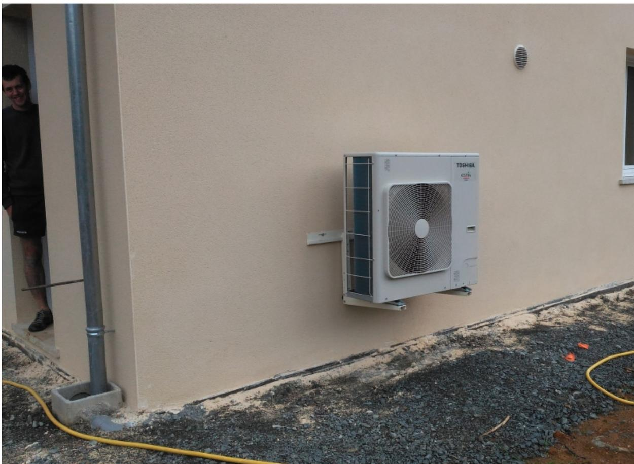
*Dans le cadre de la construction d'une maison neuve de 80m<sup>2</sup>, nous avons installé une Pompe A Chaleur TOSHIBA ESTIA 8KW . Ce modèle de PAC est particulièrement adapté au chauffage par un plancher chauffant . L'eau de chauffage est filtrée avec un filtre dégazeur Heifi Top de marque Judo, Notre technicien a effectué la mise en service. Nous avons proposé à notre client un contrat d'entretien annuel.*
