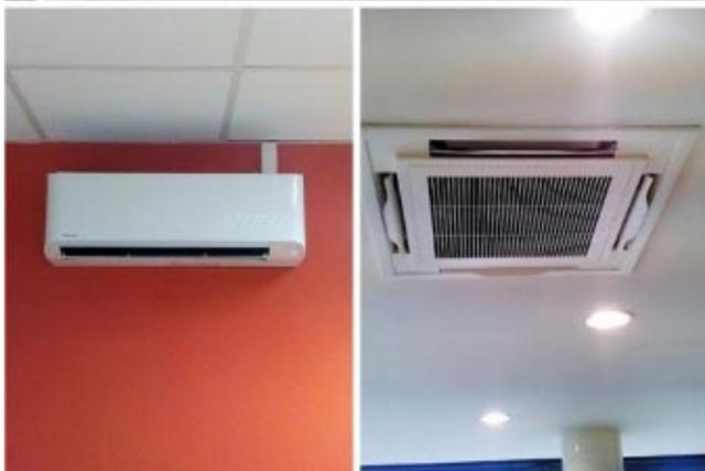
*Pour climatiser et chauffer un magasin de ventes de lunettes Optical Center nous avons installé 1 cassette TOSHIBA d'une puissance frigorifique de 14kw, Nous avons également installé un split dans le bureau de la direction . Notre technicien a effectué la mise en service. Nous avons proposé à notre client un contrat d'entretien annuel.*
