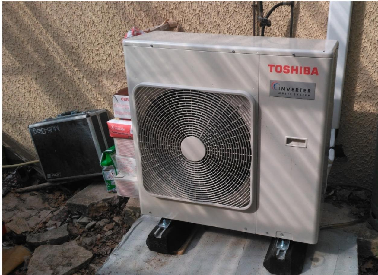
*Nous avons installé un multiplit 3 voies TOSHIBA réversible afin de chauffer et climatiser un pavillon de 80m chauffé jusqu'à présent avec des convecteurs électriques très énergivores et un poêle à bois. Notre technicien a effectué la mise en service. Nous avons proposé à notre client un contrat d'entretien annuel.*
