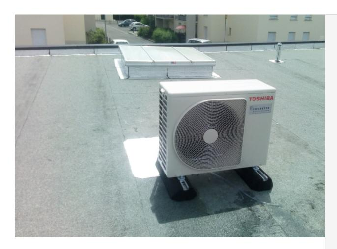
Pour climatiser une auto-école, nous avons installé un bi-split TOSHIBA. La salle de leçons de code n'ayant aucune ouverture, les séances de formation étaient très compliquées lors des fortes chaleur. L' unité extérieure à été positionnée sur le toit. Notre technicien a effectué la mise en service. Nous avons proposé à notre client un contrat d'entretien annuel.
