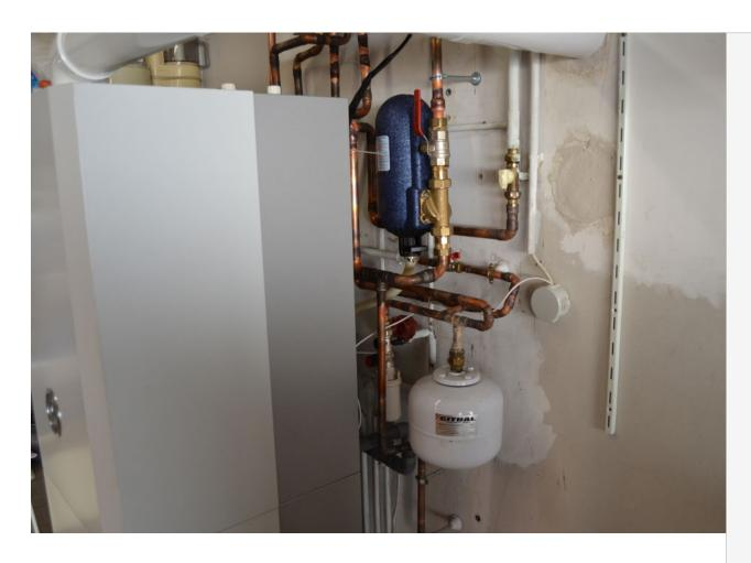
Installation d'une chaudière gaz à condensation de marque VERNE INNOVATION sur un reseau de radiateurs et un resau plancher chauffant.
