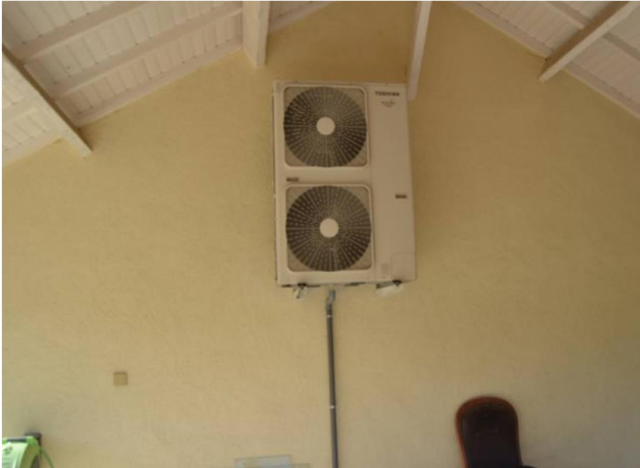
*Installation d'une pompe à chaleur Toshiba et d'un réseau de ventilo-convecteurs de marque Atlantic et Kaysun ce qui permet d'assurer le confort thermique en toutes saisons*
