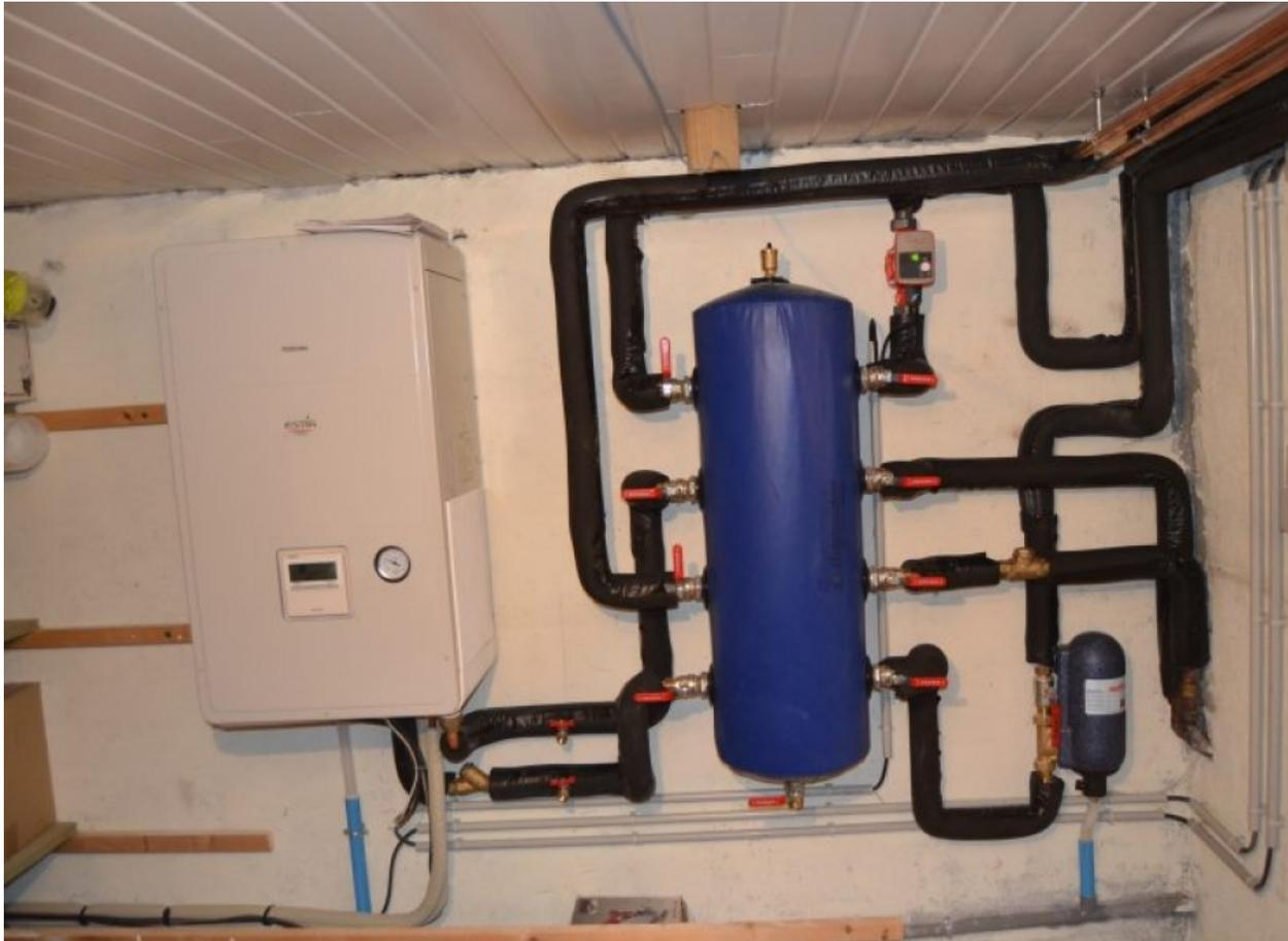
*Installation d'une pompe à chaleur Toshiba avec une chaudière gaz Viessmann en relève sur un réseau de radiateurs fonte à eau chaude*
