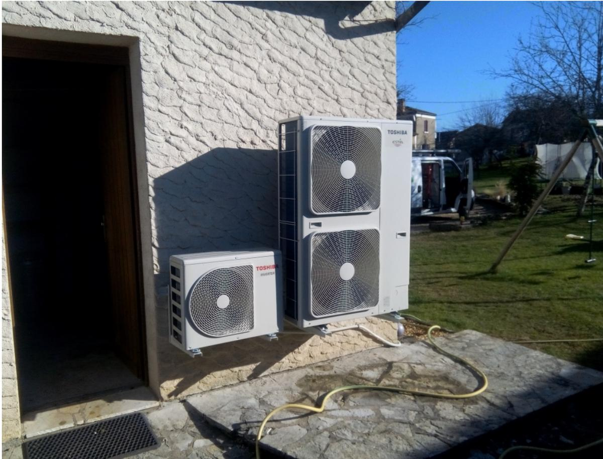
*Installation d'une climatisation réversible pour chauffer et climatiser l'étage d'une maison de campagne*
