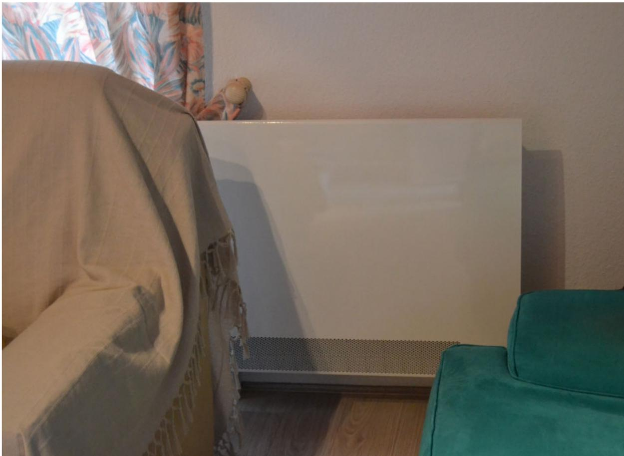
*Dans le cadre d'une réhabilitation d'une maison de village de 130m<sup>2</sup> sur 2 niveaux, nous avons installé des ventiloconvecteurs. Pour une chaleur homogène et montée en température rapide en hiver Capable de climatiser en été, associé à une pompe à chaleur réversible
