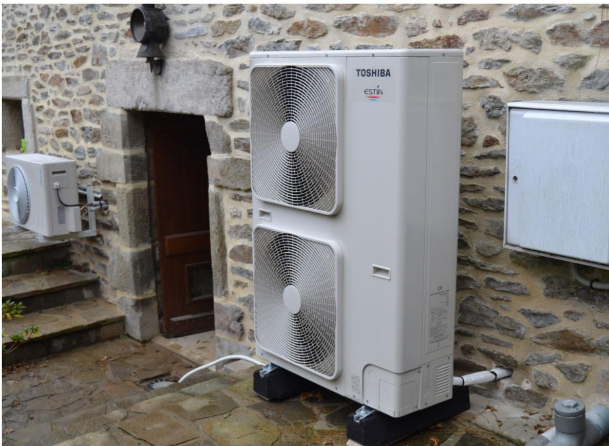
*Dans le cadre d'une réhabilitation d'une maison de village de 120m<sup>2</sup> sur 2 niveaux, nous avons installé une Pompe à Chaleur TOSHIBA EXTREME de 8kW en laissant la chaudière en relève de chauffage. Cet appareil fonctionne jusqu'à une température extérieure de -25°. Les radiateurs fonte sont dimensionnés avec un DT de 30°C. L'eau de chauffage est filtrée avec un filtre dégazeur Heifi Top de marque JUDO. Après deux hivers d'exploitation la chaudière n'a pas eu à fonctionner*
