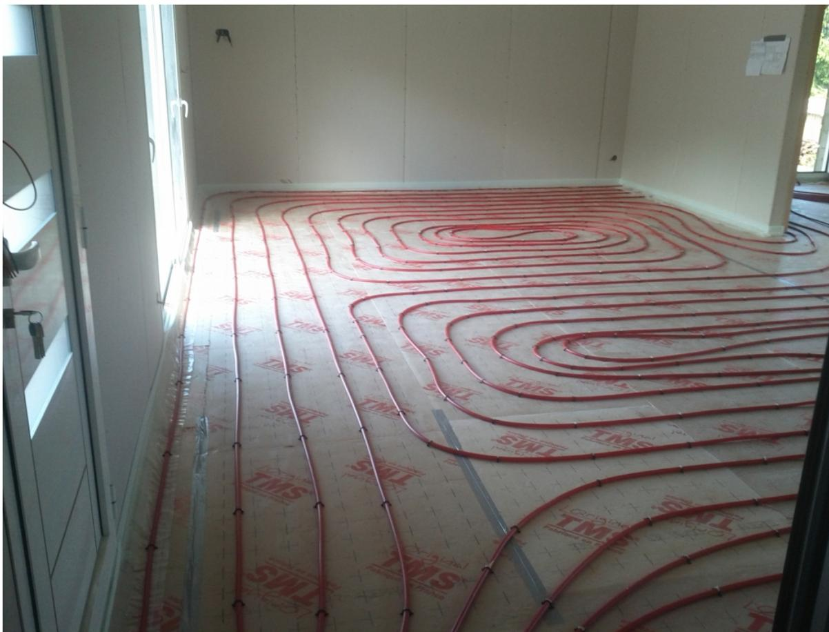
*Dans le cadre de la construction d'une maison neuve de 170m<sup>2</sup>, nous avons installé un plancher chauffant alimenté par une Pompe à Chaleur TOSHIBA ESTIA 11KW . L'eau de chauffage est filtrée avec un filtre dégazeur Heifi Top.*
